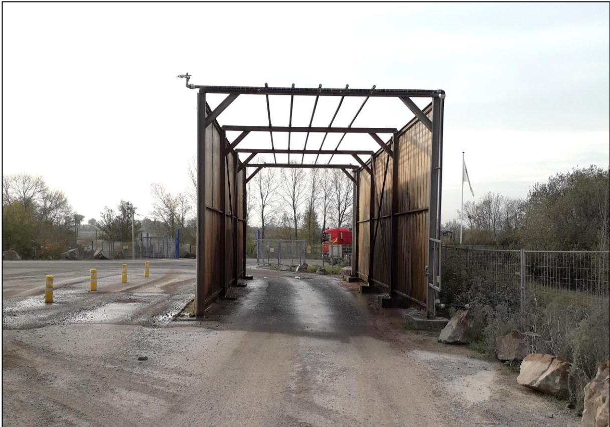
Figure 12 - Rampe d'arrosage des bennes en place
