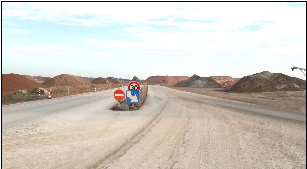
Figure 11 - Signalisation et enrobés présents à l'entrée du site
