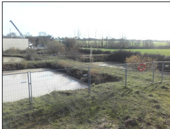
Figure 16 - Bassins de décantation en place sur la carrière de la Gouraudière prévus pour la gestion des eaux de ruissellement de l'ISDI
