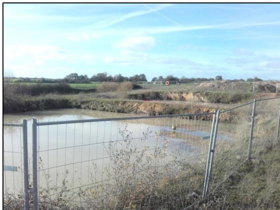
Figure 16 - Bassins de décantation en place sur la carrière de la Gouraudière prévus pour la gestion des eaux de ruissellement de l'ISDI
